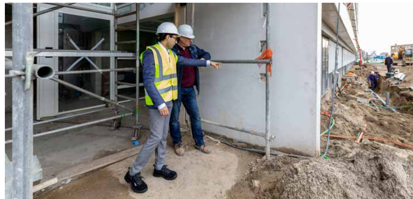
Khalid Jerrari van Comelit en George de Kok van Elektro Groeneweg Installatie.
